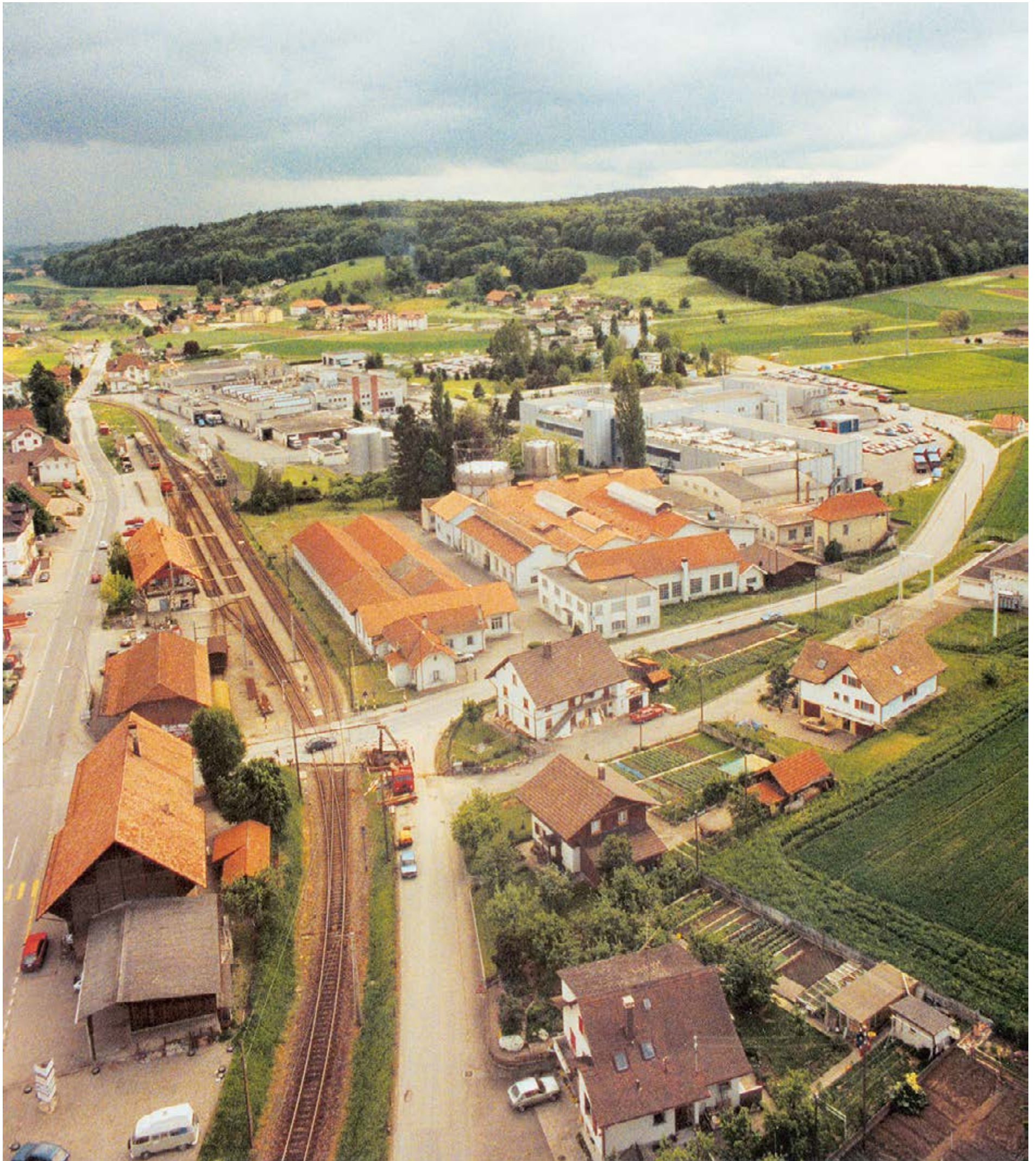
DIE MICARNA WÄCHST 25 Jahre nach der Gründung der Micarna fällt neben der mittlerweile dichteren Bebauung auch der nach der ersten Bauetappe gepflanzte Baumbestand auf.
